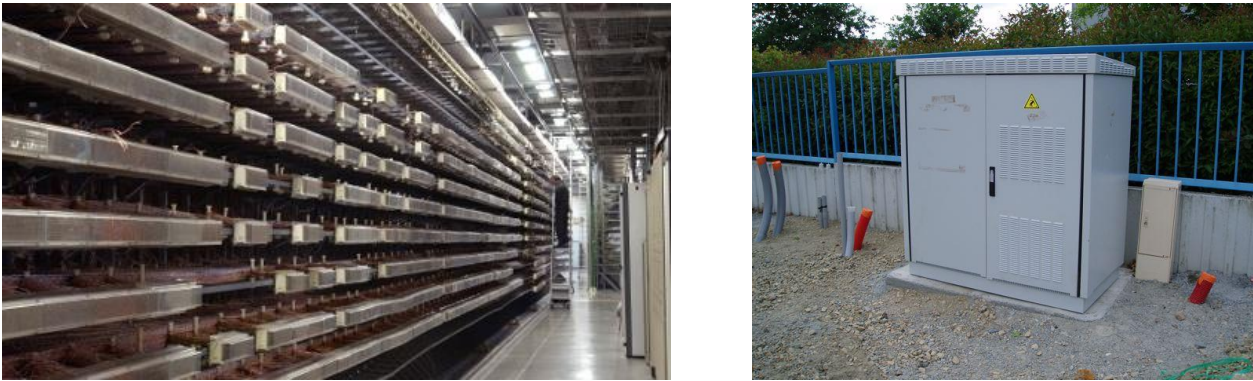
Figure 5 : Photos de deux NRA de tailles différentes.
