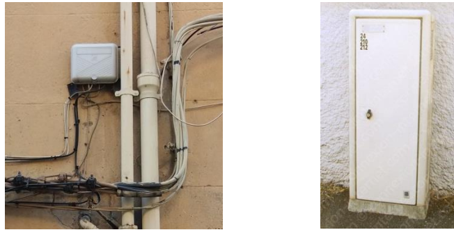
Figure 7 : Deux PC, une borne sur façade et une borne pavillonnaire.
