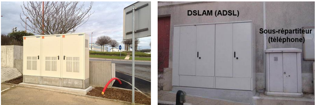
Figure 10 : Photos de deux NRA-MeD.
