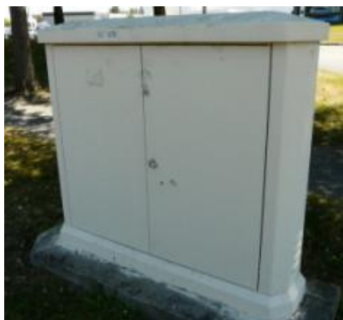
Figure 6 : Un sous-répartiteur.
